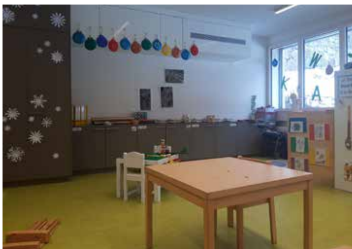
Scuola materna con unità di ventilazione decentralizzata. (Foto: FHNW)
